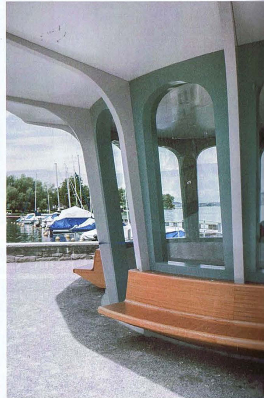
Das Wartehaus ist aus deckend gestrichenem Schweizer Tannenholz und Sperrholz gebaut, die Rundbänke sind aus Eichenholz.
