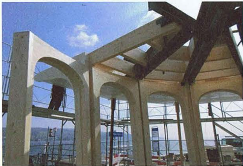
Wand- und Deckenelemente im Rohzustand während der Aufrichte.
