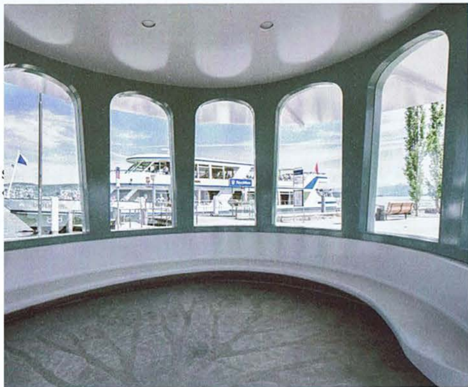
Die runde, nach aussen geneigte Wand ist mit ihren konischen und gebogenen Gläsern in der baulichen Umsetzung eine Herausforderung.
