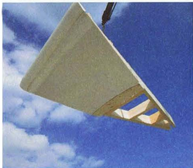
Ein Dachsegment, vorgefertigt und montiert von der Widmer Zimmerei AG.
