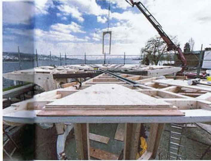
Die Aufrichte der vorgefertigten Elemente ist weniger komplex als die Konstruktion selbst.
